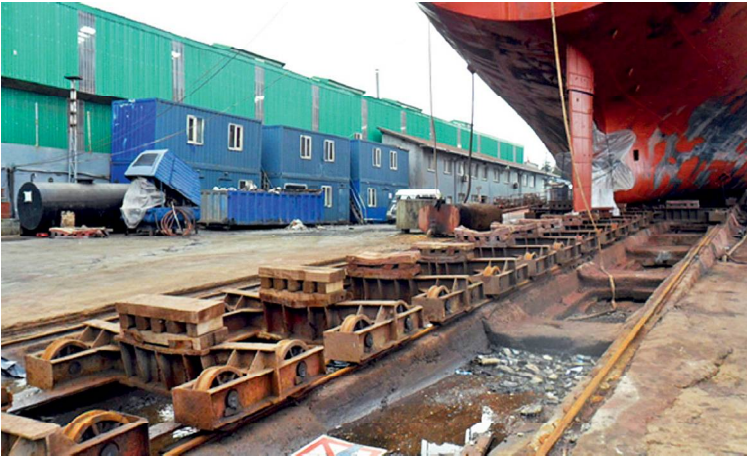
Şekil 3. Deprem performansı incelenecek betonarme raylı kızak görüntüsü.
