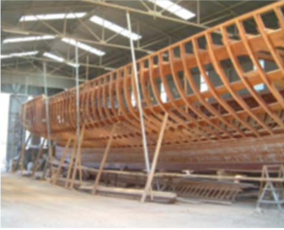
Şekil 17: Ahşap bir guletin postaları ve kaplama başlangıcı (Muğla-Bodrum, 2007) [1].
