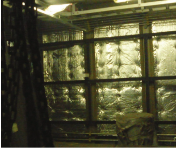
Şekil 13. Makine dairesi izolasyonu
