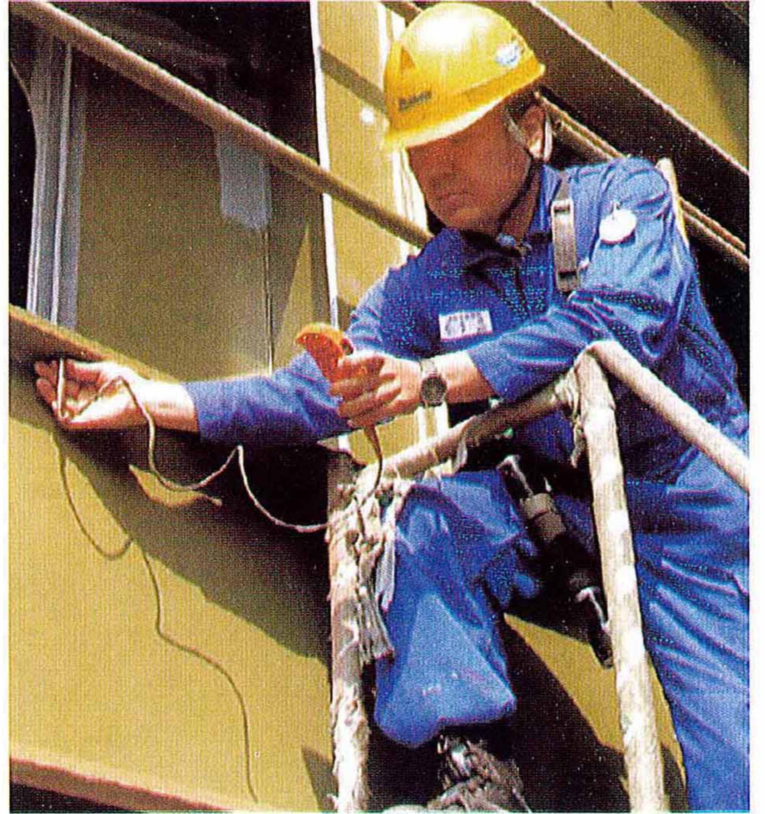
Fotoğraf 1. Boya kalınlığı ölçümü.
